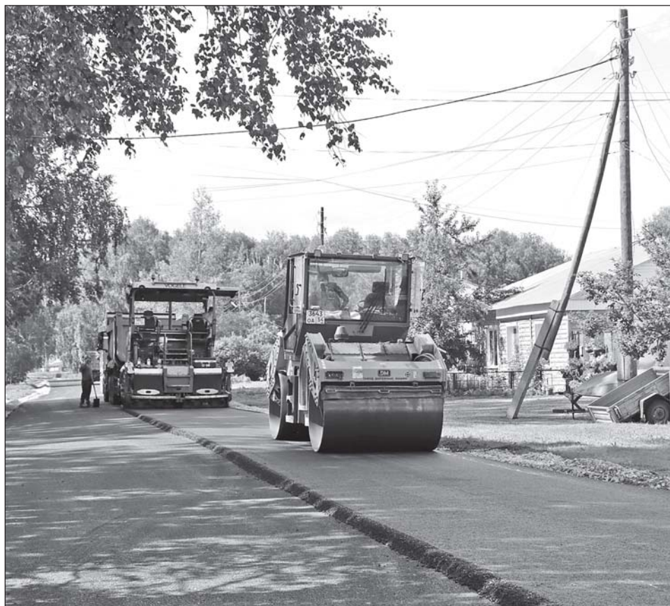
■ Ремонт дороги на улице Лесной.
