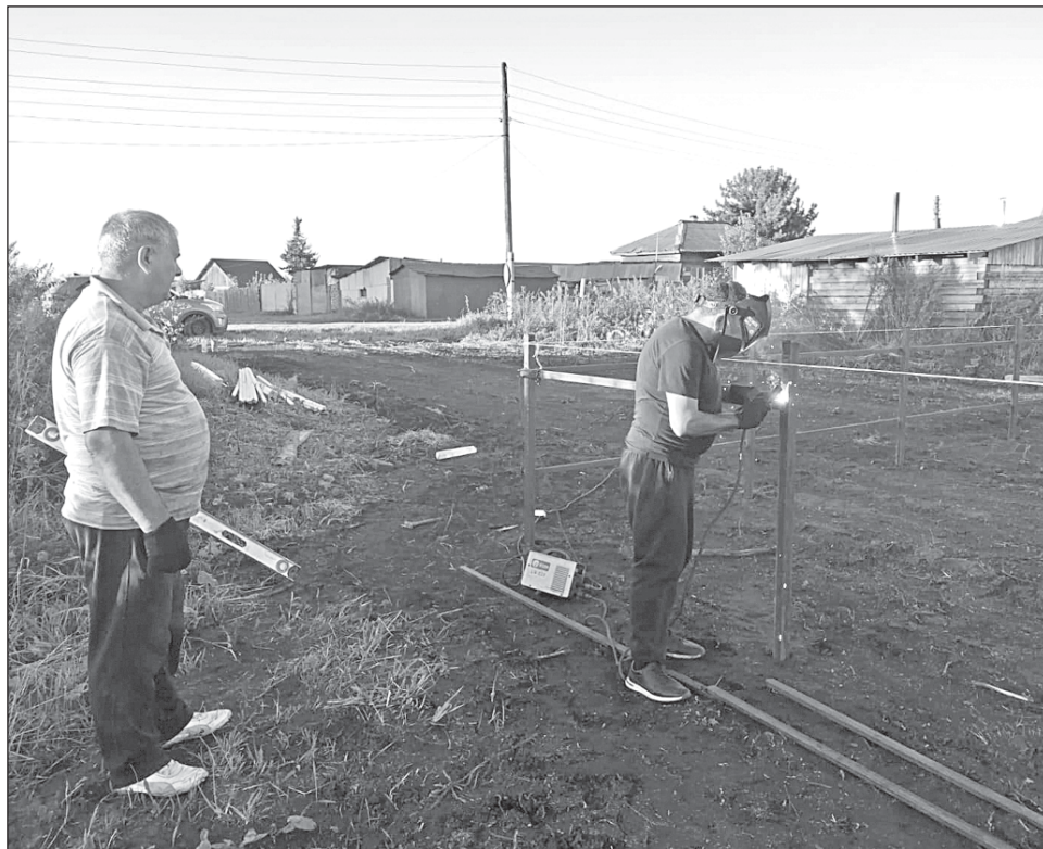
■ Обустройство детской площадки в Батурине.
